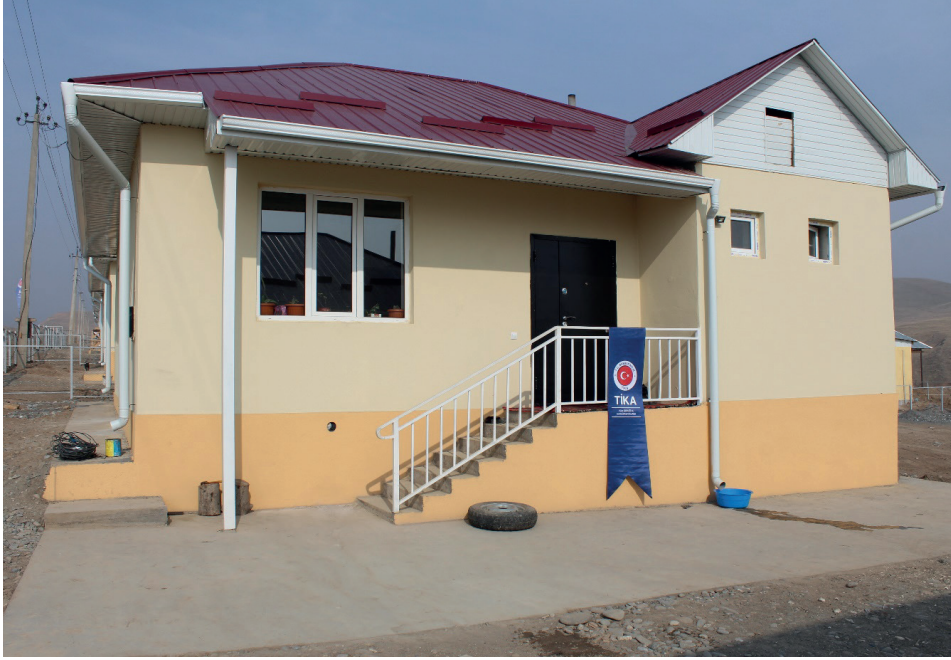
Kırgızistan Heyelan Mağdurlarına Konut İnşası
