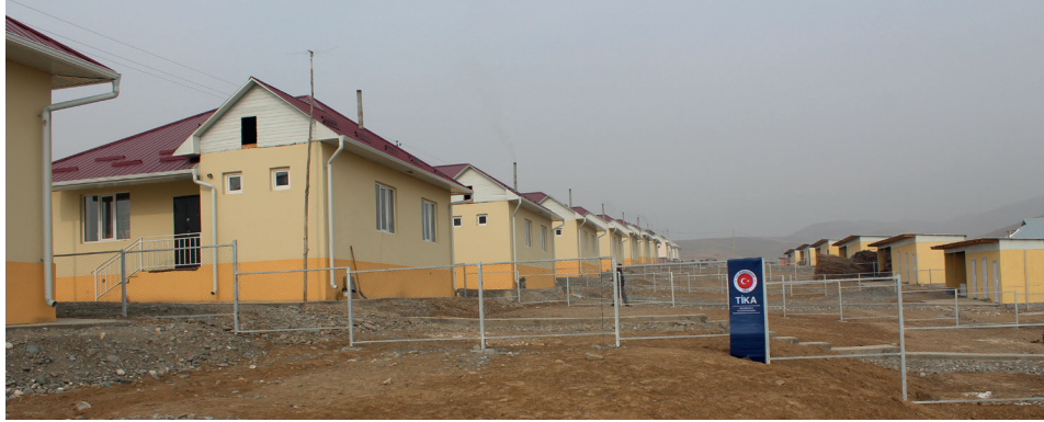
Kırgızistan Heyelan Mağdurlarına Konut İnşası
